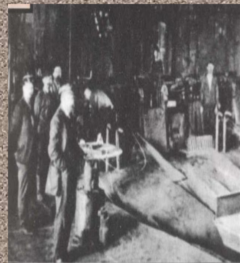
Днепропетровский металлургический завод на Екатеринославщине, нач. XX в.
